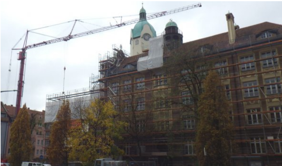
Beim Abbau und Wiederversetzen der Werksteine am Giebel.
