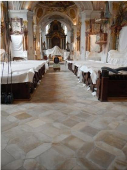
Der Blick in den Kirchenraum nach dem Verfügen. Anschließend wurde der Boden abgedeckt, ein Innengerüst gebaut und die Raumschale restauriert.
