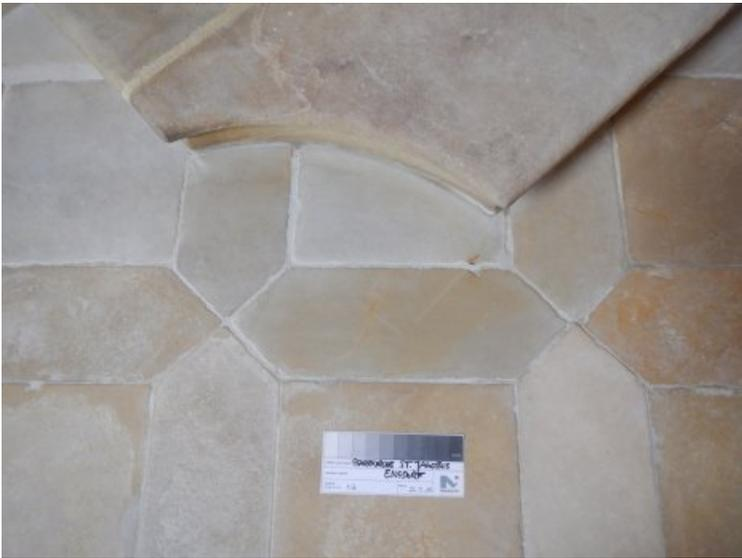
Die gebrochenen Bodenplatten wurden durch Neuteile ersetzt.
