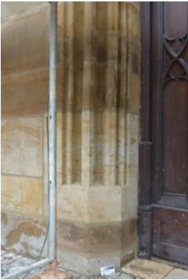
Der unterste profilierte Gewändestein wurde durch ein Neuteil ersetzt.
