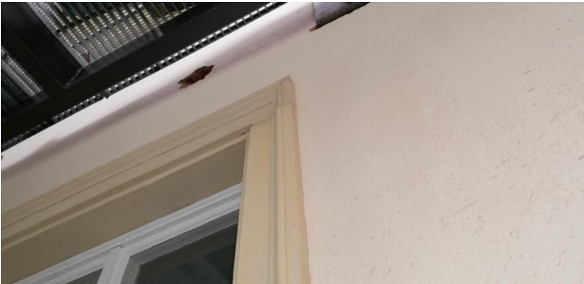
Beispielhafte Ansicht der profilierten Bauteile und der Neuverfugung
