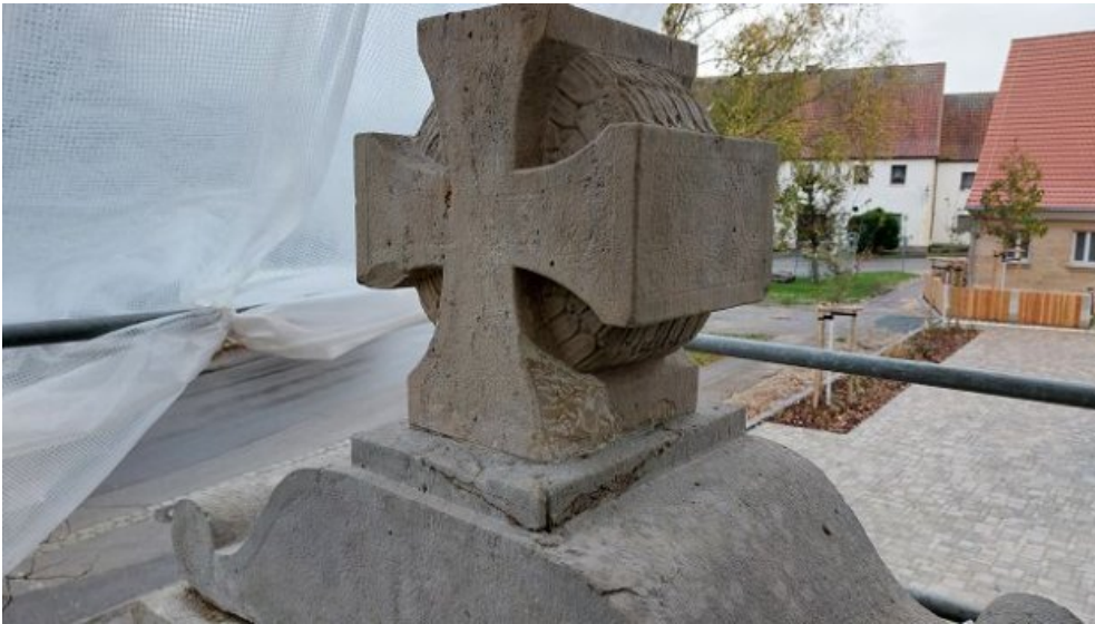
Ausgearbeiteter Bereich am Kreuz als Vorbereitung auf die Mörtelergänzung.
