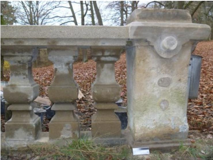
An der Brüstung bestehen Sockel, Postamente und ein Teil der Baluster aus Sandstein, der andere Teil der Baluster und Handlauf sind aus Kunststein.
