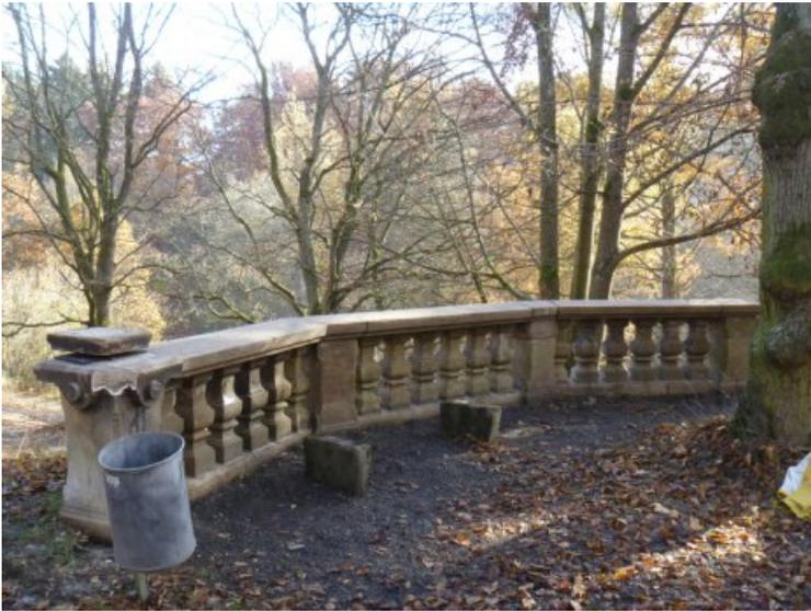
Nach Reinigen und Ausarbeiten defekter Bereiche - die Fehlstellen, Risse und Fugen sind noch nicht geschlossen.
