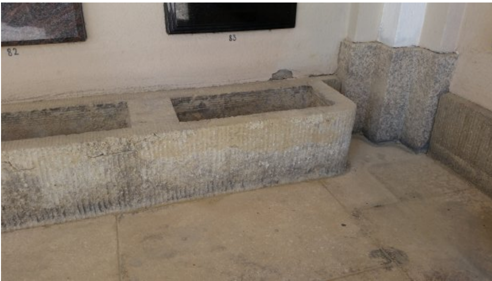
Zwischenzustand: Betonkübel nach Überarbeitung der Mörtelergänzung.
