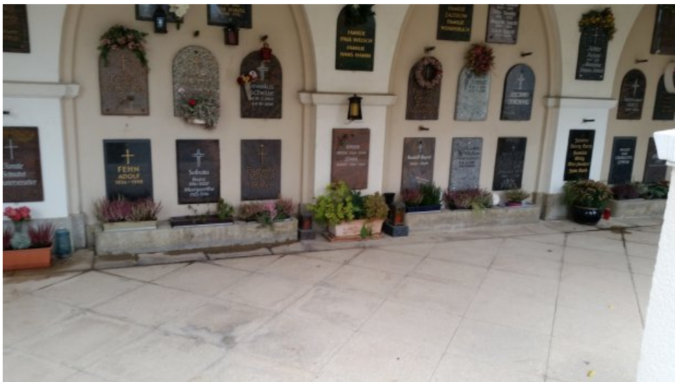
Nachzustand: Betonkübel nach der Maßnahme mit Bepflanzung.
