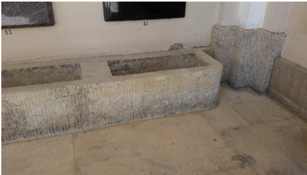
Zwischenzustand: Betonkübel nach Überarbeitung der Mörtelergänzung.
