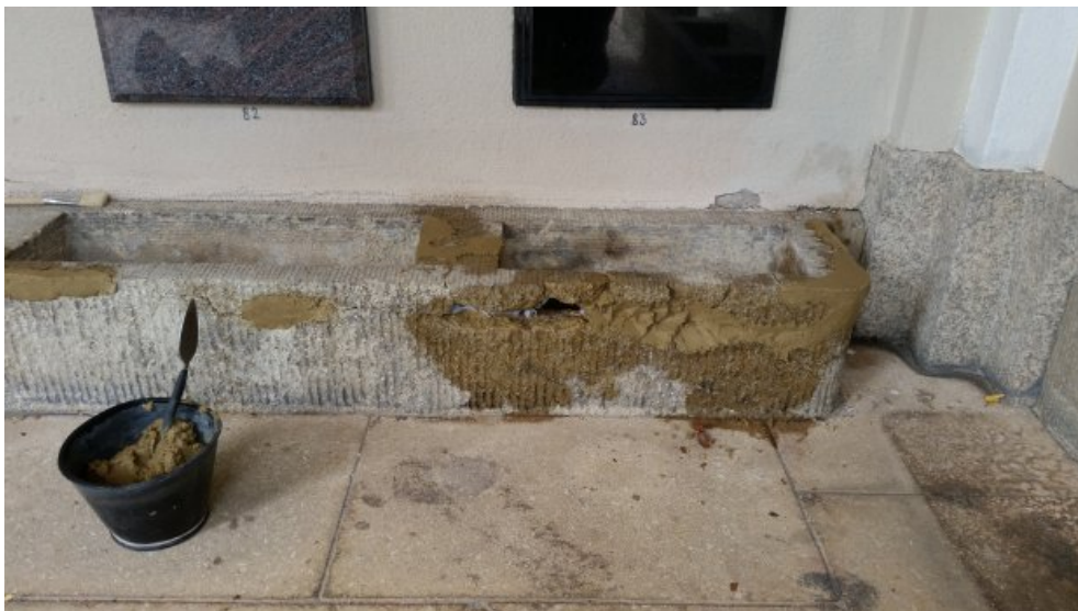
Zwischenzustand: Detail vom Ergänzungsprozess und Rissverschluss eines Blumenkübels mit mineralischer Ersatzmasse.
