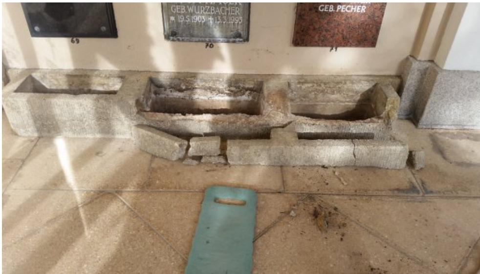
Zwischenzustand: Abbau der durch den Riss entstandenen Bruchstücke.
