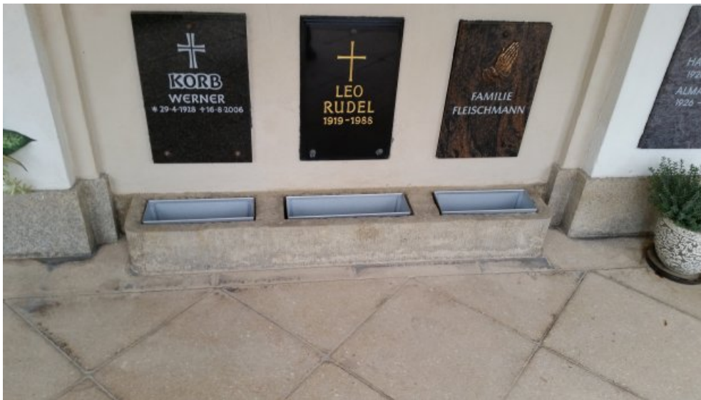
Zwischenzustand: Die restaurierten Blumenkübel mit einsetzten, neu gefertigten Metallpflanzkübeln.
