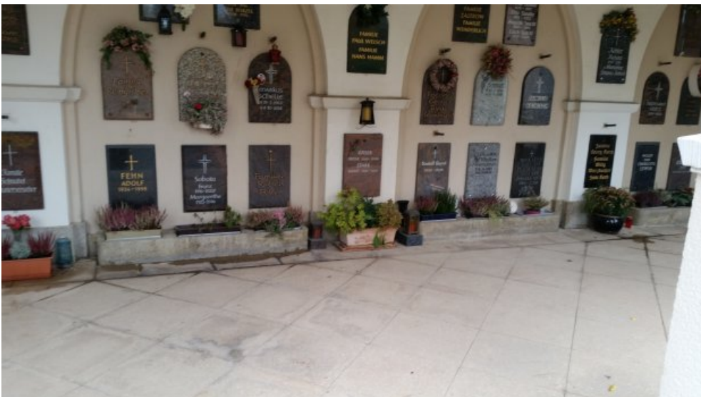
Nachzustand: Betonkübel nach der Maßnahme mit Bepflanzung.
