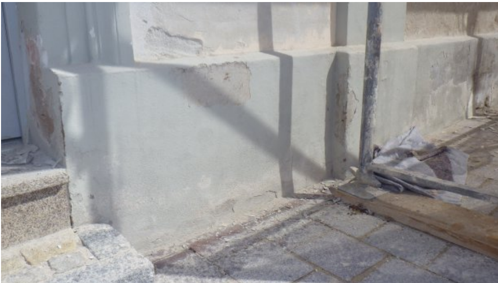
Das Sockelmauerwerk vor der Restaurierung mit Beschichtung.
