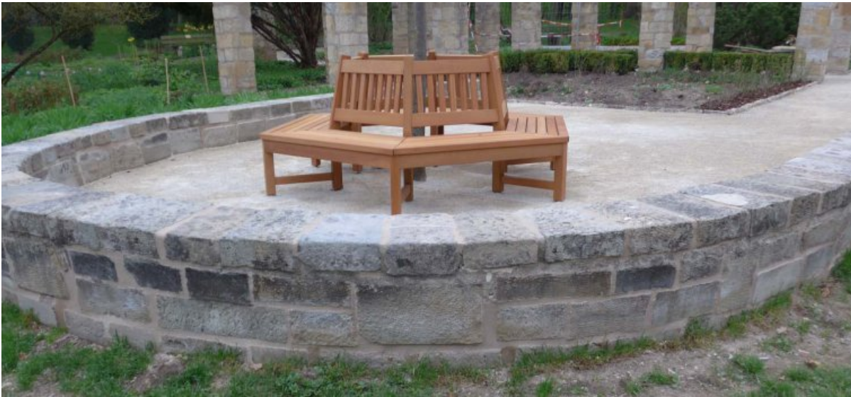
Die Einfassungsmauer um den neu gepflanzten Baum nach der Restaurierung.
