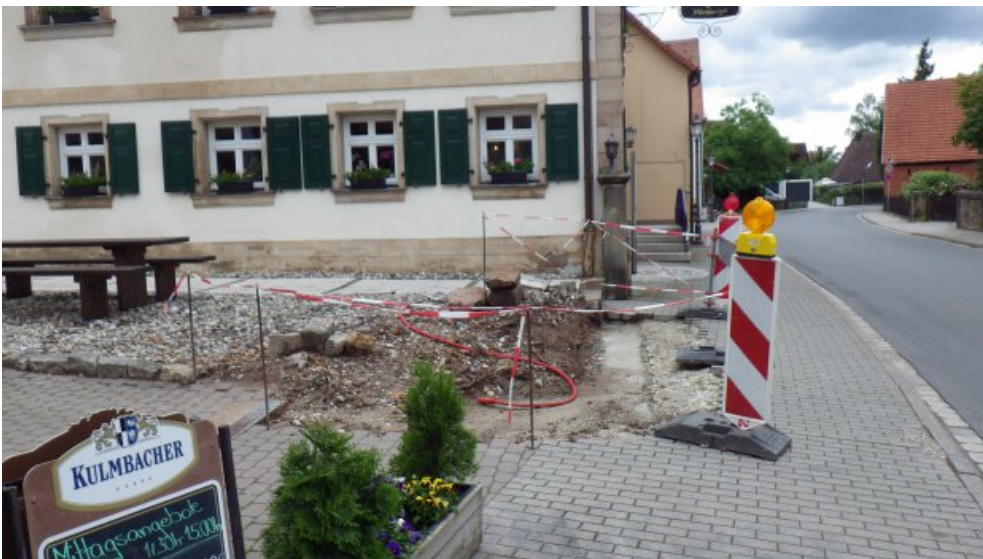
Nach Abbau der Mauer, die Mauerwerksteine wurden seitlich gelagert.
