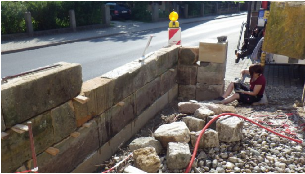
Während des Wiederaufbaus.
