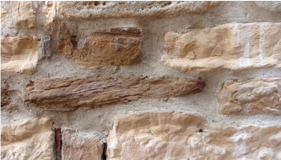
Das erneuerte Fugenbild wurde zurückgesetzt gearbeitet und fügt sich harmonisch ein.
