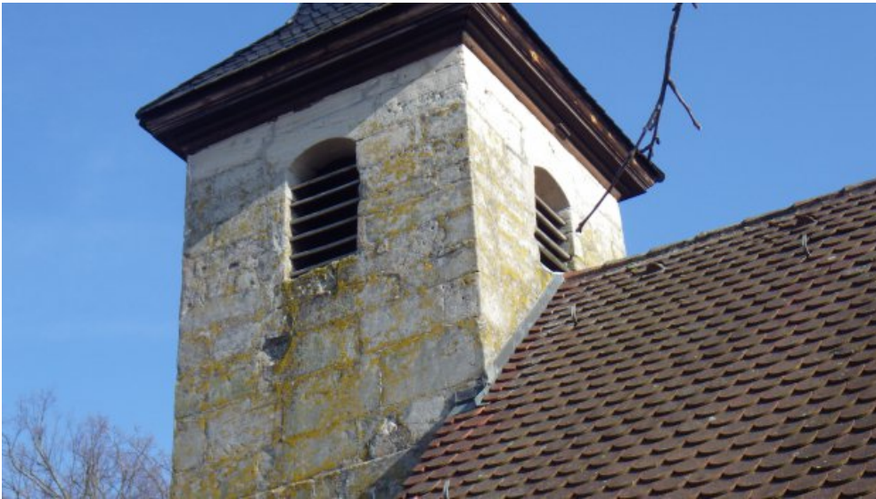
Detail des Turms vor der Restaurierung.
