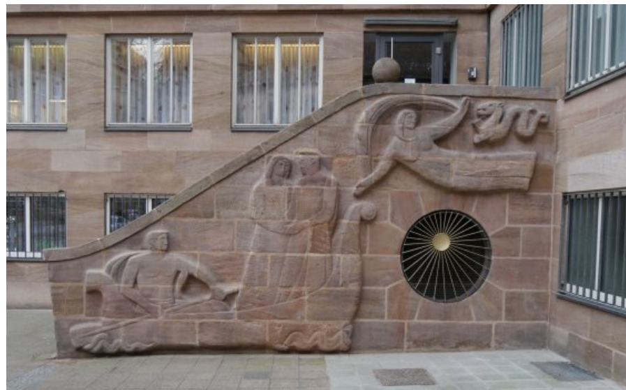
Die Brauttreppe des Neuen Rathauses in Nürnberg nach der Konservierung und Restaurierung.
