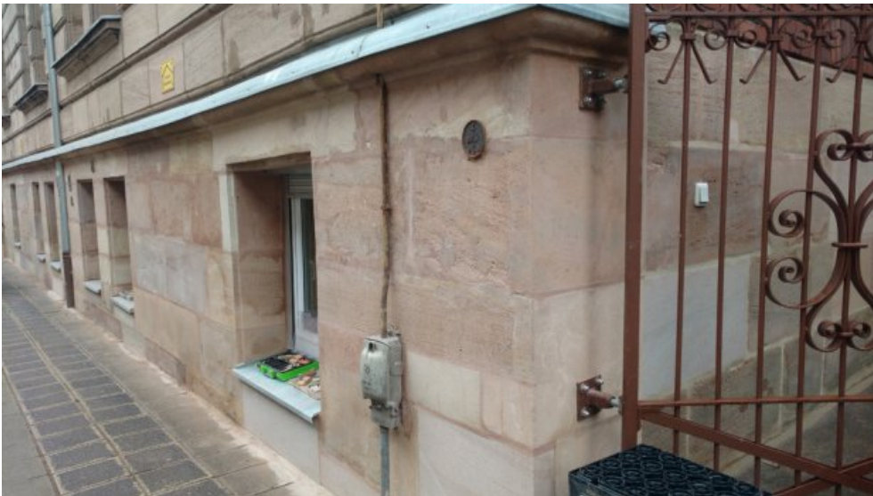
Der Sockel nach der Restaurierung.
