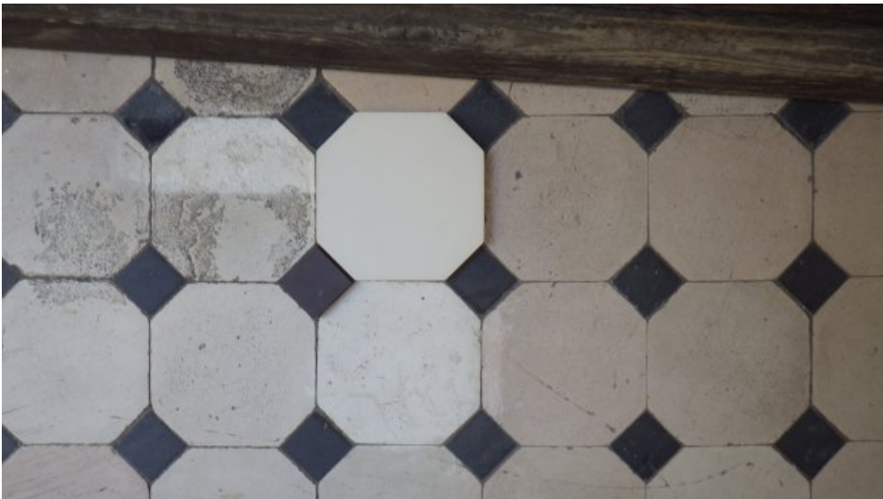
Nach der Reinigung wurden Probestfliesen bestellt und farblich passende Bodenfliesen ausgewählt.
